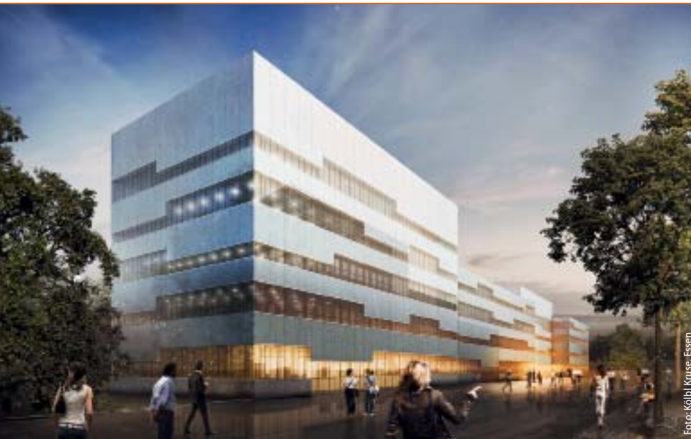
Abb. 1: Außenansicht des Neubaus für den Fachbereich Gestaltung der Folkwang Universität. Die Fassade aus verzinktem Stahlblech steht für die Robustheit und für den Industriecharakter des Zechestandortes.
