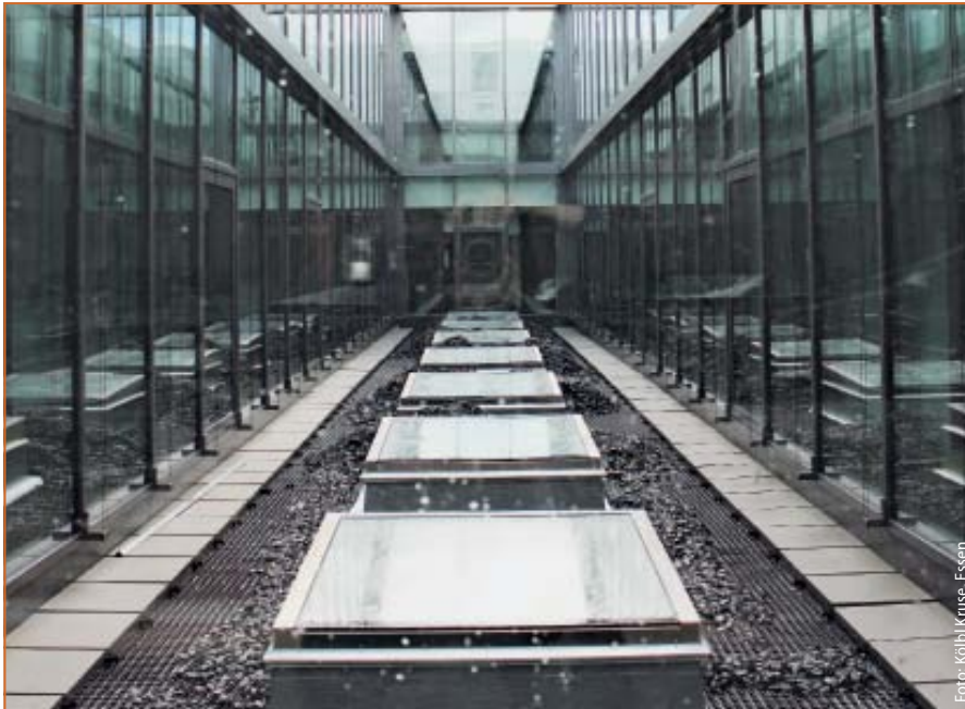
Abb. 4: Die Draufsicht der Rauchableitung im Innenhof des Kubus 2
