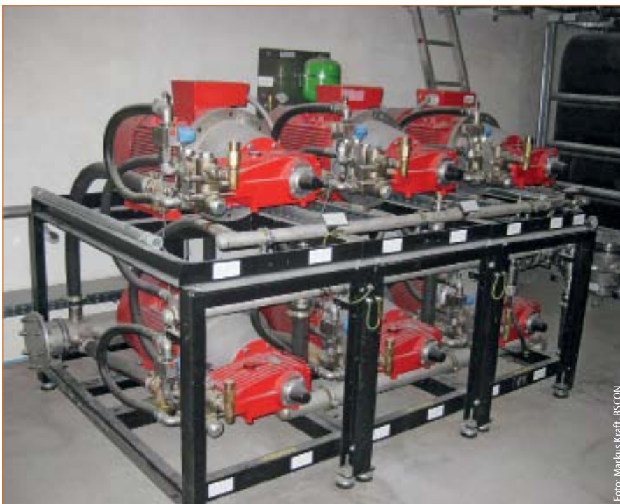
Abb. 6: Hochdruckpumpen der HDWN-Löschanlage
