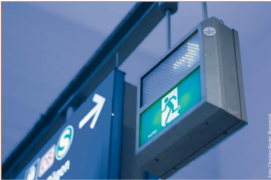
Abb. 5: Dynamisches Fluchwegleitsystem
