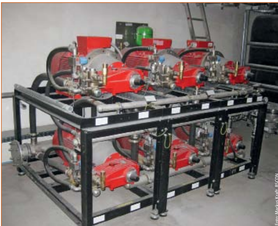
Abb. 6: Hochdruckpumpen der HDWN-Löschanlage
