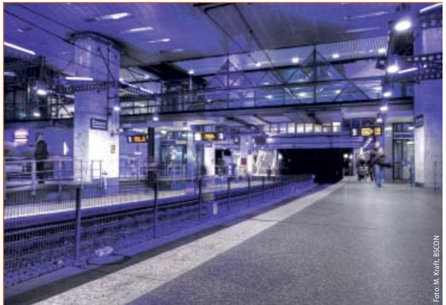
Abb. 2: Die U-Bahn-Station weist eine maximale Ausdehnung von 190 m × 140 m auf und befindet sich ca. 6,50 m (Verteilerebene) – 11 m (Bahnsteigebene) unter der Erdoberfläche.
