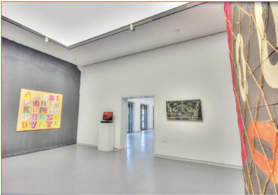
Abb. 2: In den Ausstellungsräumen wurden moderne Lichtdecken mit Spannfolie erstellt.
