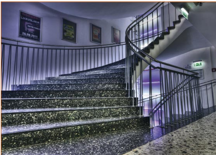
Abb. 3: Eine offene und gewendelte Freitreppe als einer der zentralen Rettungswege im Objekt
